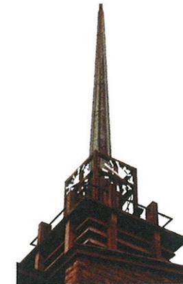
forment l'ossature de l'église et supportent le **grand clocher central** ; ce dernier est construit en béton avec sa succession d'abat-sons qui peut évoquer le chevalement d'une mine. Sa flèche culmine à 42 m de hauteur, véritable signal de l'église. A l'instar de l'architecture médiévale donnant à voir la
