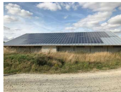
Production électrique photovoltaïque
