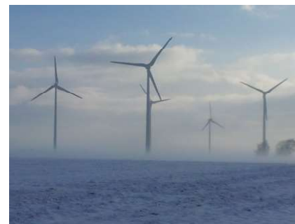
Production électrique éolienne
