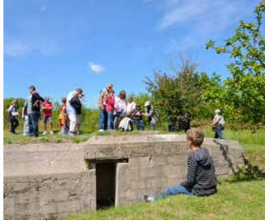
Les Batteries du Mont-Canisy, Bénerville-sur-Mer
