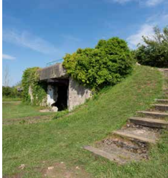
Les Batteries du Mont-Canisy, Bénerville-sur-Mer
