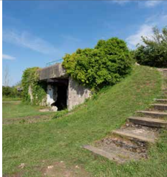
Les Batteries du Mont-Canisy, Bénéville-sur-Mer
