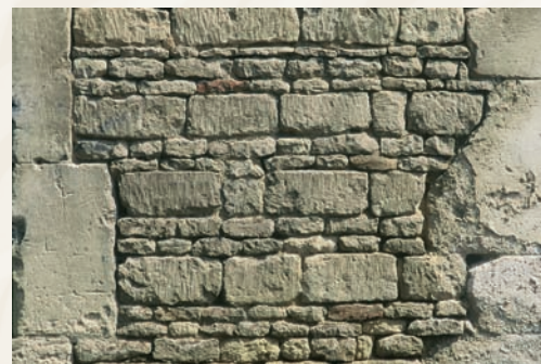
Un détail d'appareillage laissant apparaître le matériau géologique : plaquette calcaire et calcaire massif.
